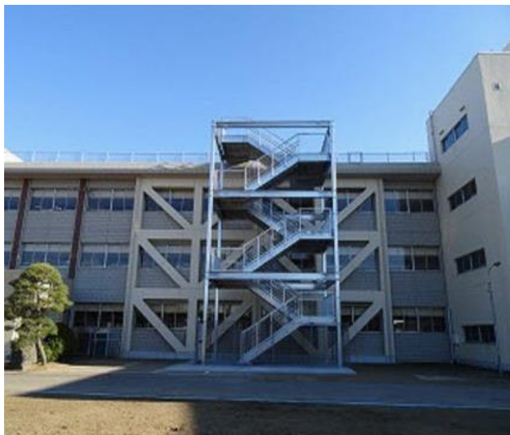
グラウンド側から見た非常階段
