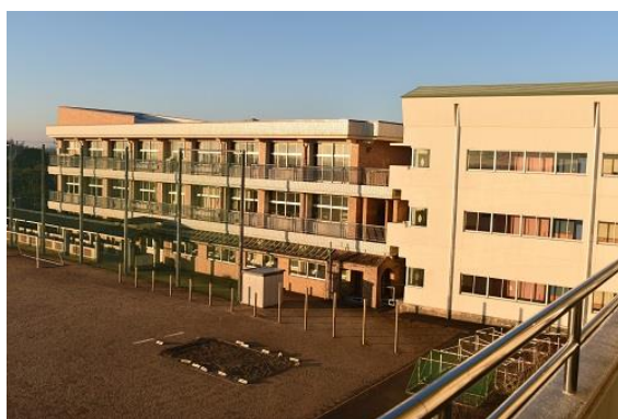
3階から見た特別棟
